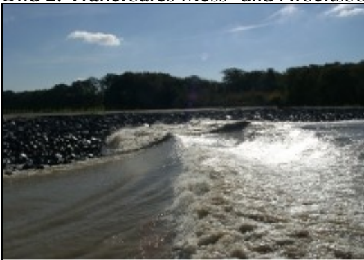
Bild 3: Schiffserzeugte Wellen an einen Uferdeckwerk bei schneller, ufernaher Fahrt
